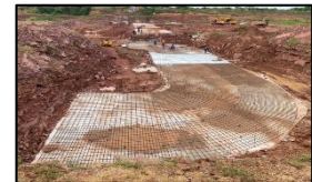
งานเหล็กเสริมคอนกรีต
