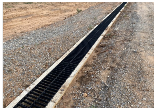
รูปที่ 1-20 ความก้าวหน้าการก่อสร้างงานรางระบายน้ำ
